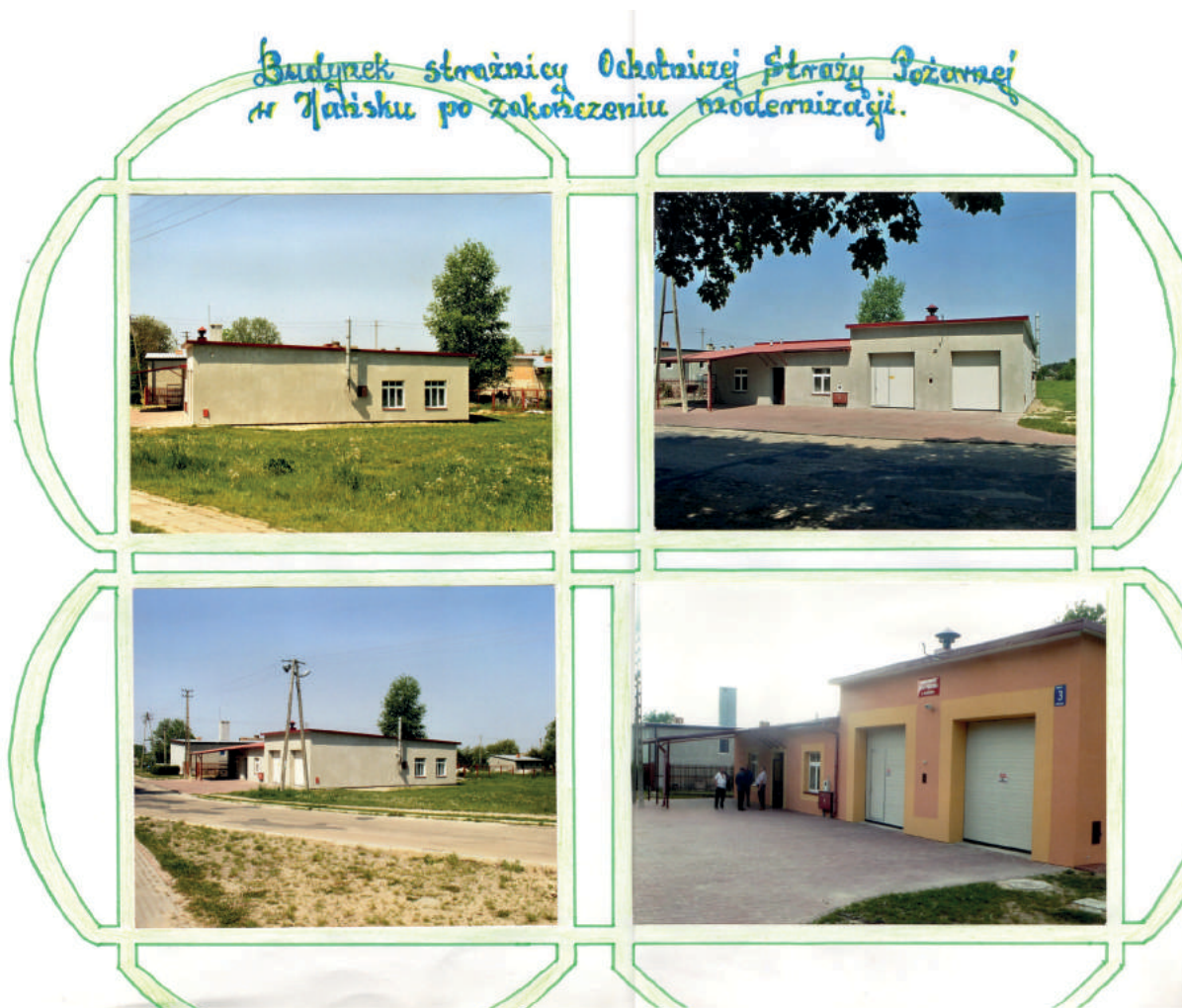
Budynek OSP w Hańsku po zakończeniu modernizacji – 14 lipca 2007 roku
