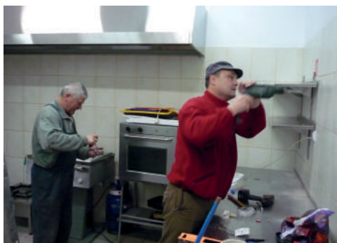
Wszystkie prace związane z montażem urządzeń kuchennych strażacy wykonali we własnym zakresie. Kazimierz Kiecka i Wojciech Grunwald przygotowują miejsce na nową kuchnię gazową
