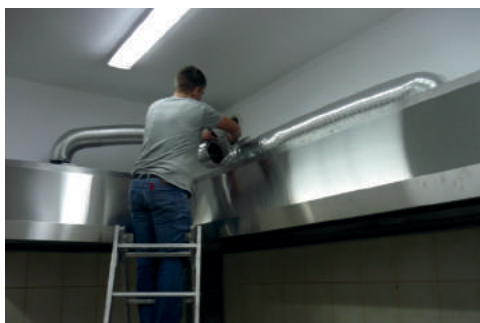
Wszystkie prace związane z montażem okapu i systemu wyciągowego strażacy wykonali we własnym zakresie. Michał Krawczyk montuje system wyciągowy
