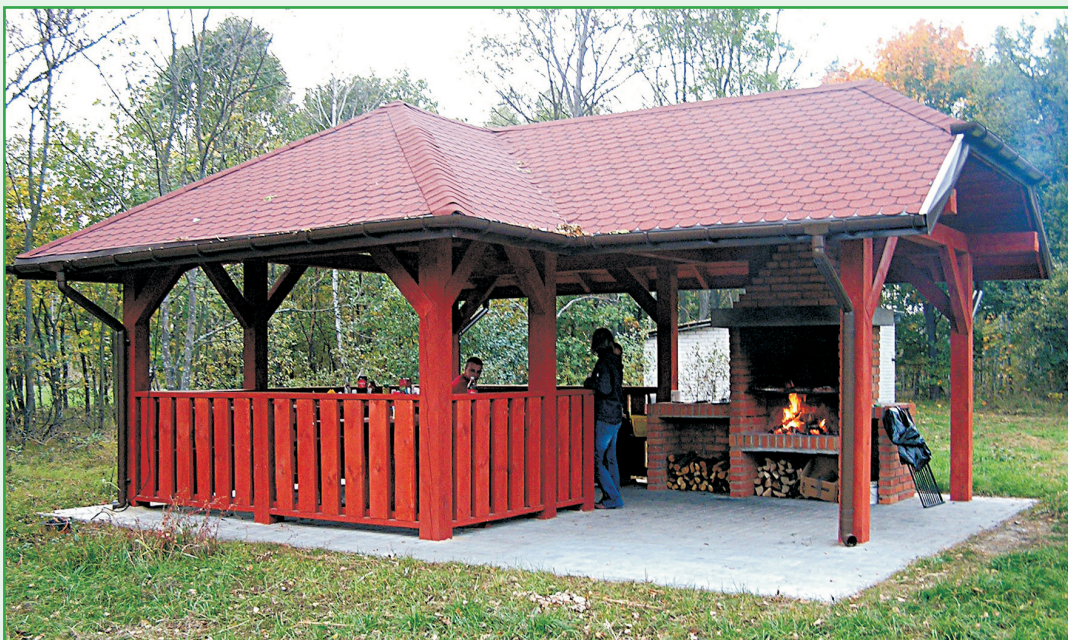
Zadaszenie w miejscowości Bukowski Las
